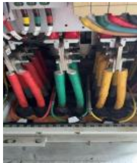
现场罗氏线圈安装实景示意
