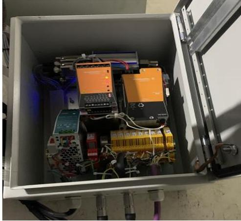
产品主要针对 strain- 4 channels 及 4\*n 通道应力应变数据采集设备，可进行同步，分布式(基于 ETH)并行的数据采集，同时具备本地存储远程回放，恶劣工况下安装运行，多类型数据高低频信号传输操作，最大同步多通道并行实时采样 100S/s.
